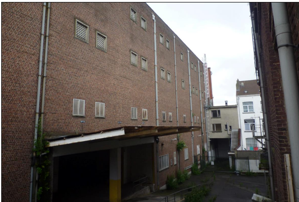
Photo 5 : Vue sur la façade de l'immeuble St-Michel, côté cour intérieure
