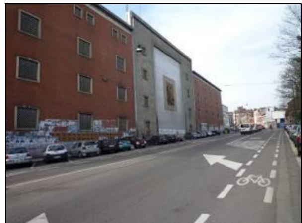
Photo 12 : Rue Picard, vue de l'organisation du stationnement au droit du site
