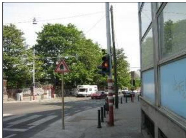
Photo 18: Rue Picard vue au départ de sa section comprise entre la rue de l'Escaut et le boulevard du Jubilé
