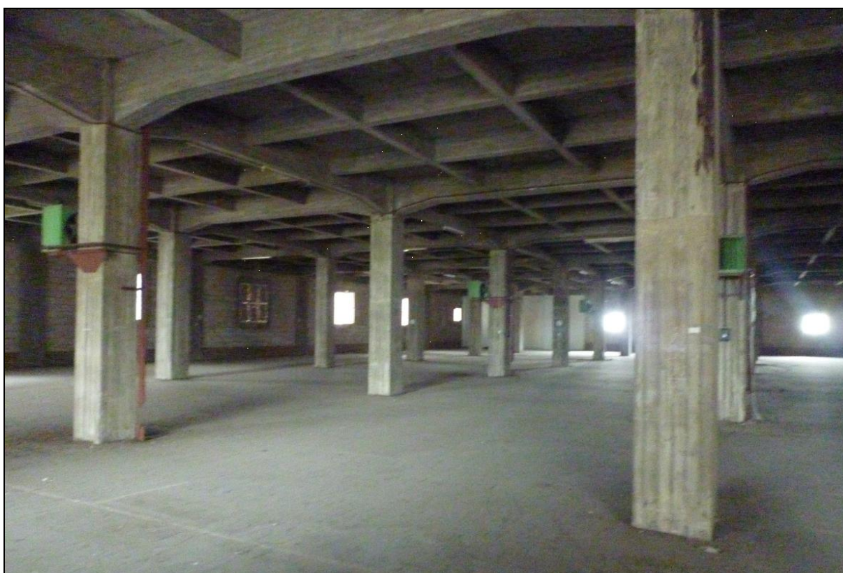
Photo 6 : Vue de l'intérieur de l'immeuble St-Michel et sa structure
