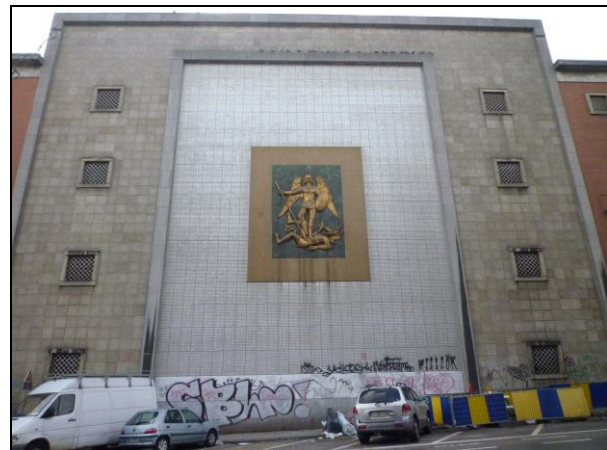
Photo 16 : Façade de l'immeuble côté Picard
