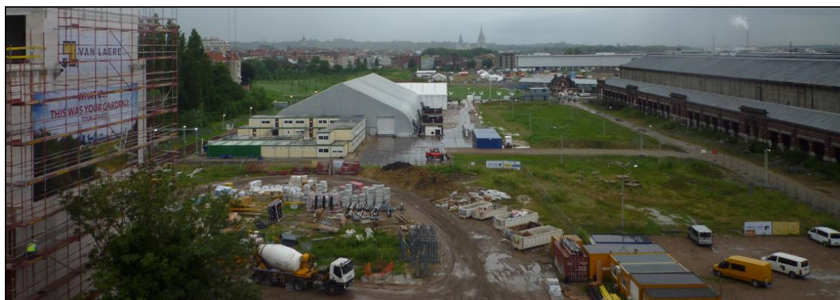
Photo 31 : Vue depuis le niveau toiture en direction de « Tour et Taxis »
