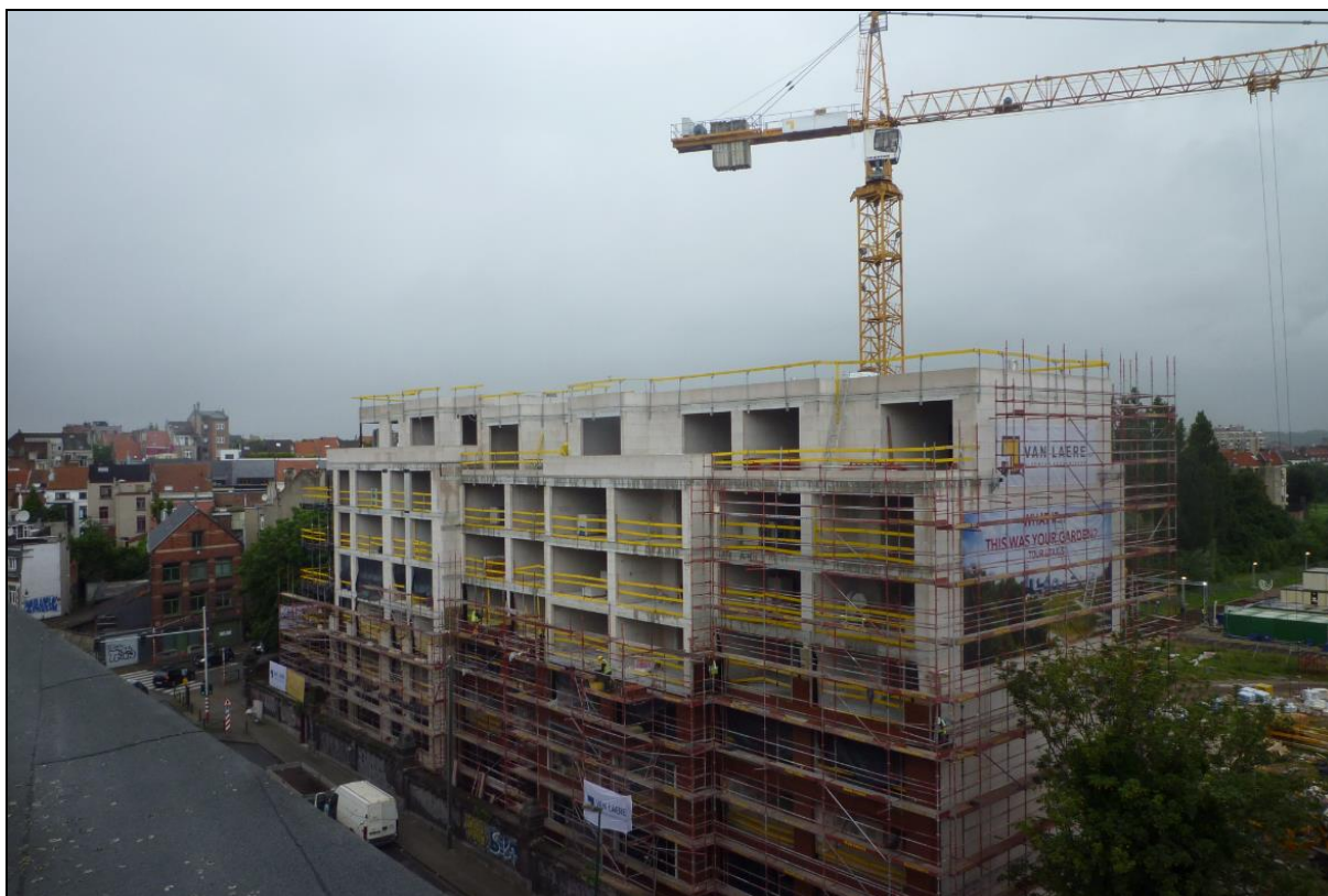
Photo 7 : Vue depuis la toiture de l'immeuble St-Michel vers l'immeuble de logements en cours de construction sur le site de Tour et Taxis (Septembre 2016)
