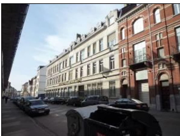
Photo 23: Rue Vandenboogaerde, au niveau de l'immeuble « Barcardi – Martini »
