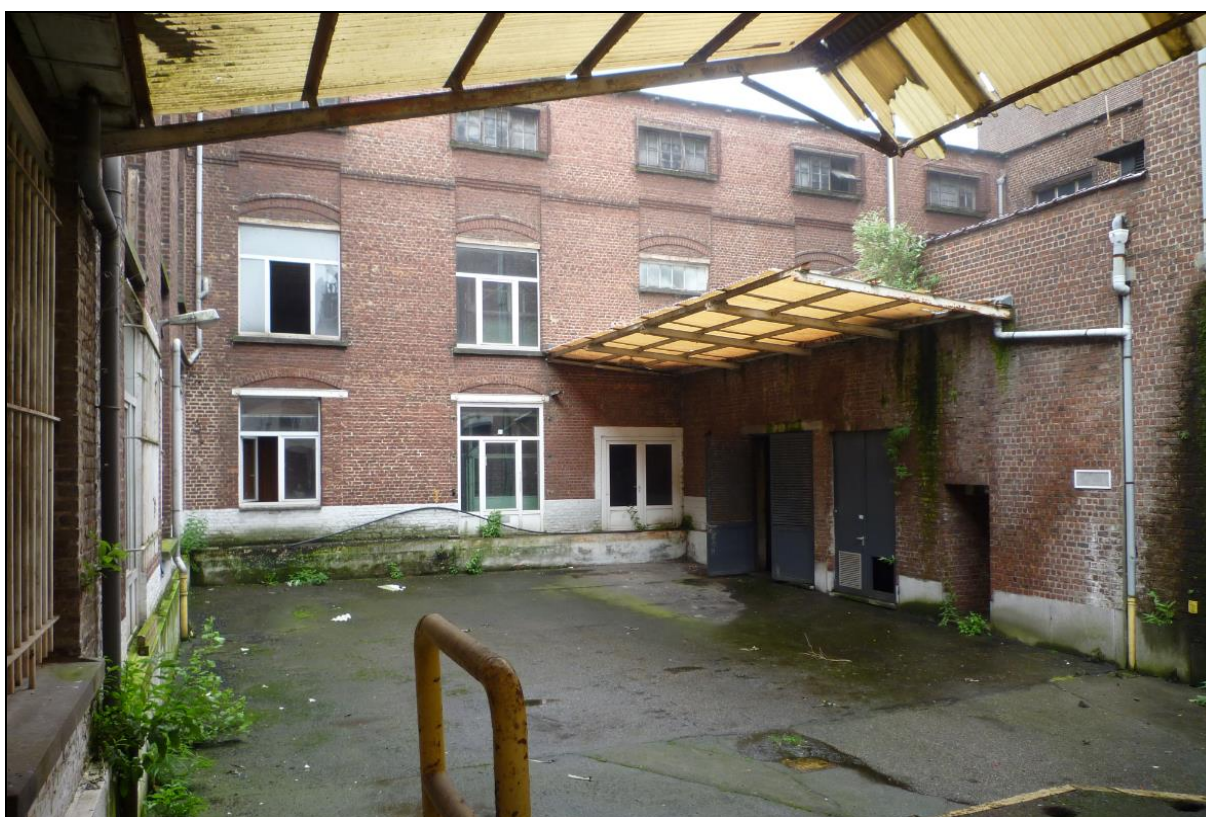
Photo 4 : Vue sur la cour intérieure et le bâtiment en L
