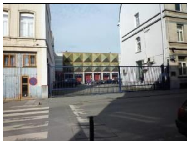
Photo 24: Rue Vandenboogaerde, accès carrossable vers le parking et quais de l'immeuble « Barcardi - Martini »
