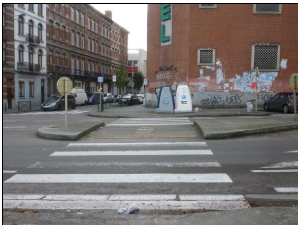
Photo 28 : Vue de la traversée piétonne aménagée (dalles podotactiles) rue Picard, au droit du site
